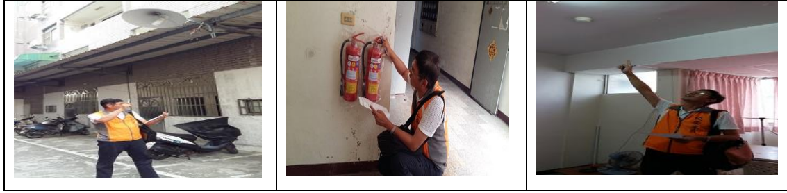
卅八、5月7日(覆檢合格)：楠梓區朝明路223巷1號(大器學舍)租屋群警、消租屋安全評核情形
