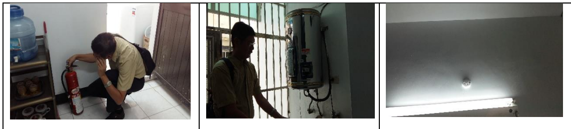
四十一、5月21日(覆檢合格)：高雄市楠梓區清平街20之1號6樓租屋群安全評核情形
