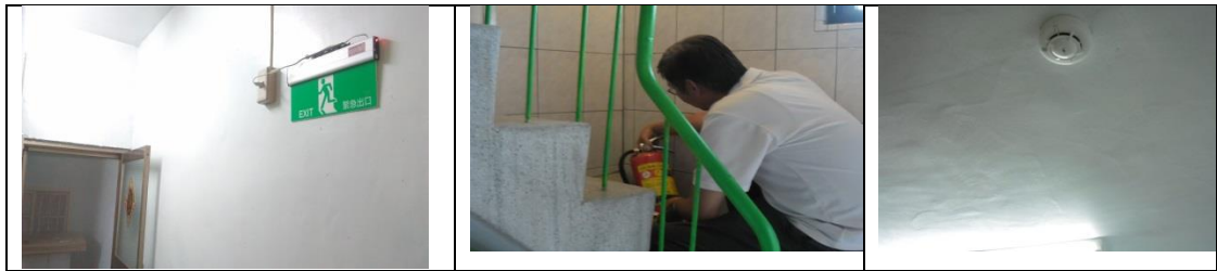
七、11月6日(覆檢-合格)：燕巢區深興路98巷6-6號(陳00-電話：0938-566311)租屋群警、消租屋安全評核情形
