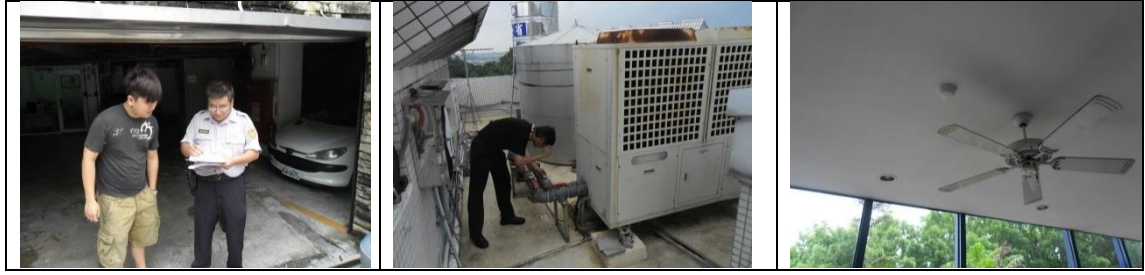
六十一、6月8日(覆檢-合格)：燕巢區深中路57號租屋群警、消防屋安全評核情形
