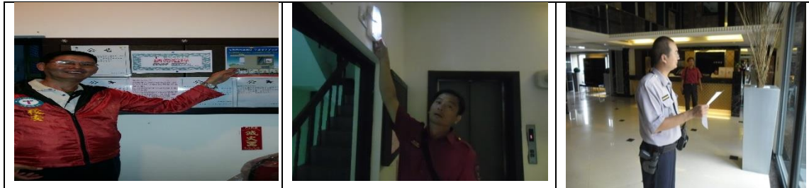
廿四、12月12日(覆檢-合格)：高雄市楠梓區興楠路355巷83號菁英會館-雄四館租屋群警、消防屋安全評核情形
