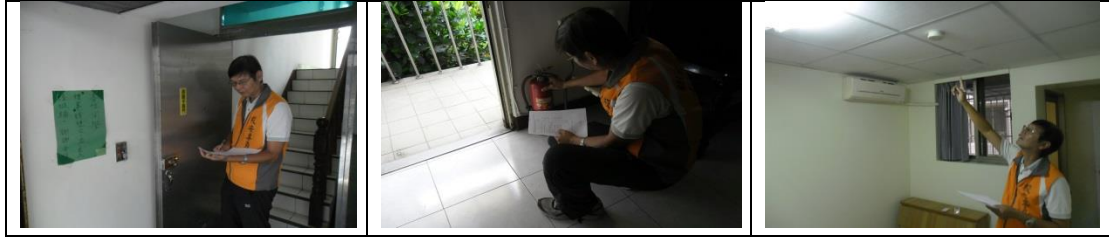
八、11月20日(覆檢合格)：楠梓區卓越路251號(巨理興業 ALL PASS 學苑張經理-0932793907)租屋群警、消防屋安全評核情形
